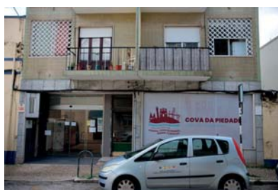
Posto de atendimento da Cova da Piedade
