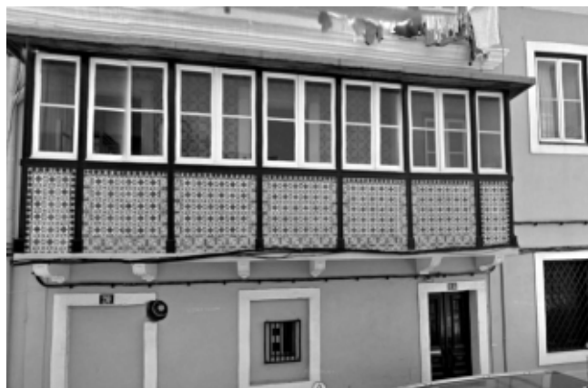
Instalações da Escola das Salgadeiras, Rua das Salgadeiras n.º 18
